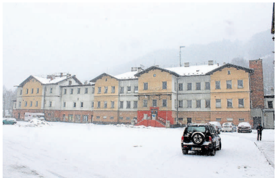
DŮLEŽITÉ, ALE NEHEZKÉ. Hanušovické nádraží je nejdůležitější železniční křižovatkou v Jeseníkách. Do oprav výpravní budovy se zde však investovalo málo. Foto: Deník/Petr Krňávek
